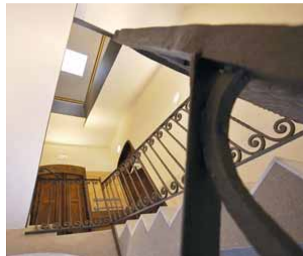
Per fases El castell, en acabar la tercera tanda d'obres.
