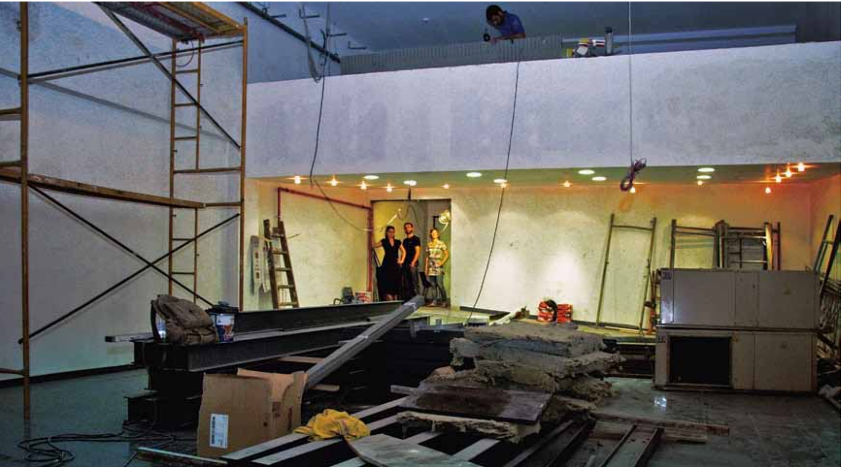
A la platea, les obres interminables.
