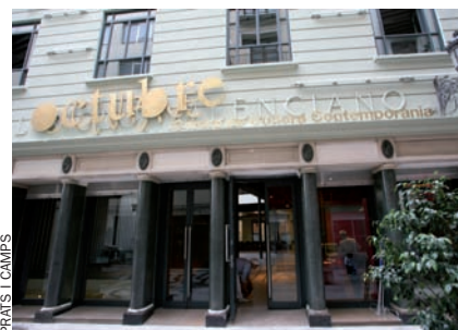
Edifici de l'Octubre CCC, a València.
